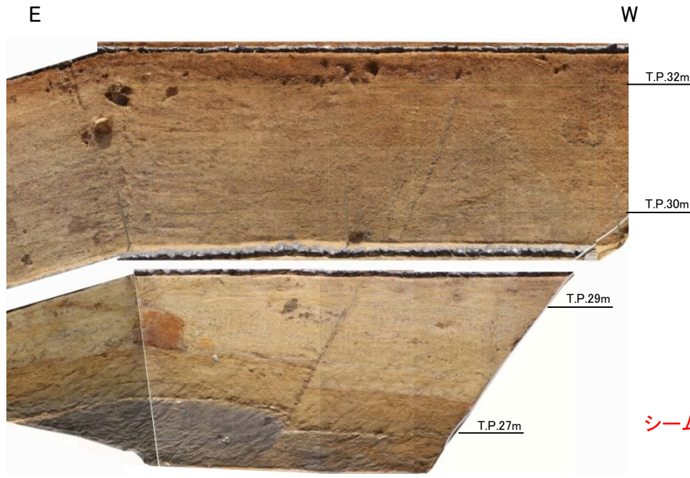
図2.1 Tf-5(a)トレンチ南側法面写真
