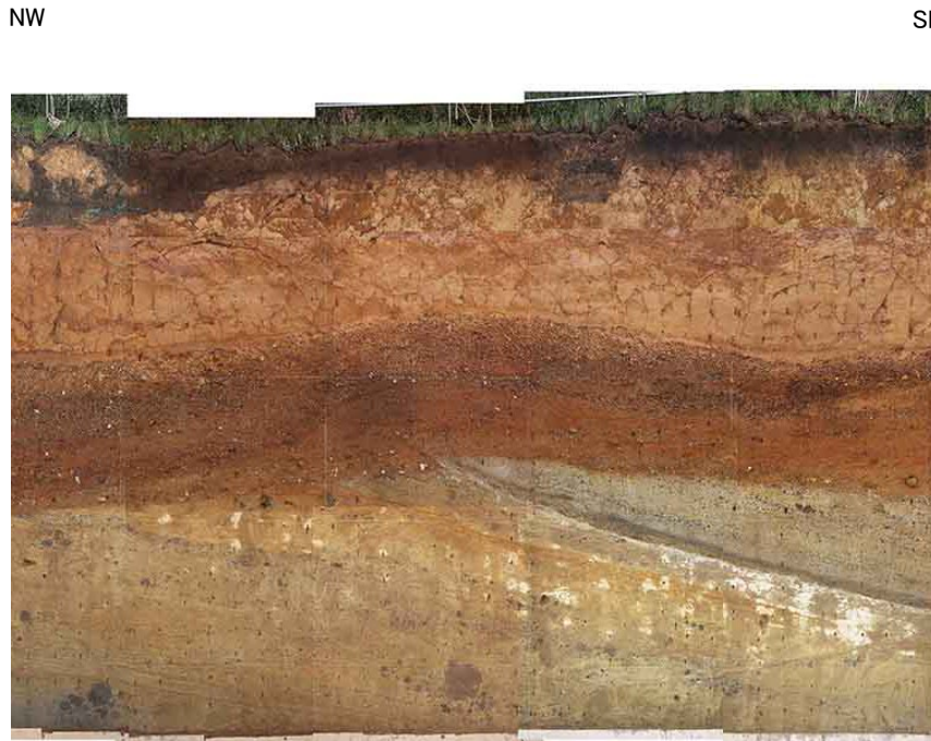
図4.3 法面写真(Ts-6法面)
