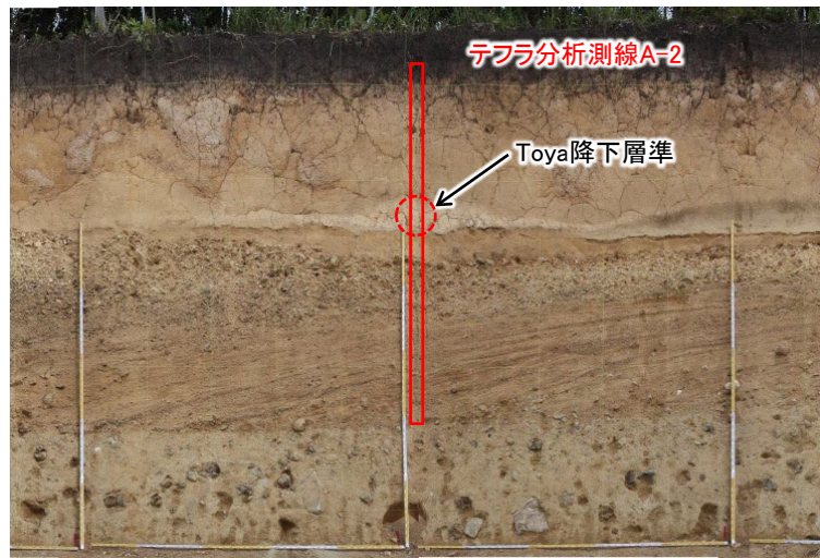
図1.2 法面④詳細画像
