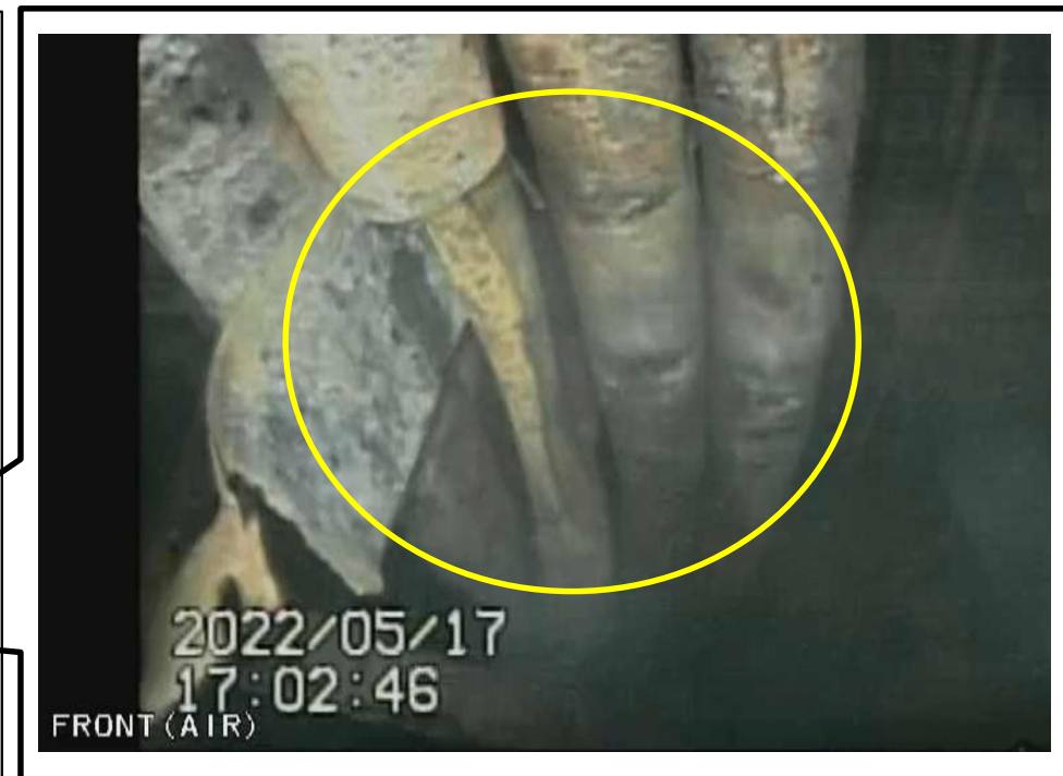
写真2. D/W内配管の状況
