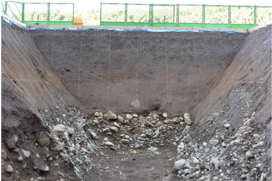
図 2.6.5 増掘前掘削状況
