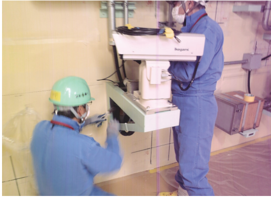
図 6.1.A1-5 監視カメラ電線管移設①
