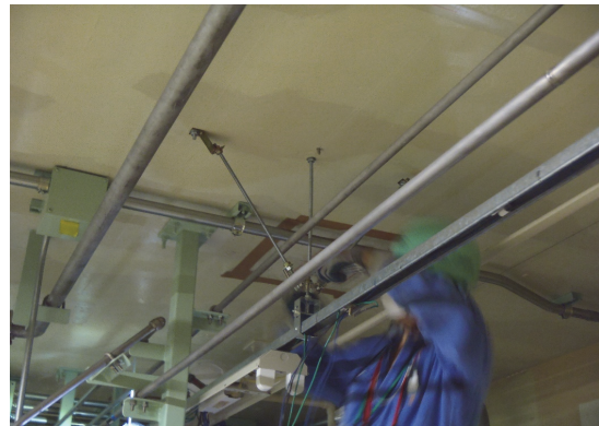
図 6.1.A1-8 照明設備の撤去・移設②
