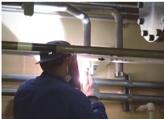
図 6.1.A1-11 切断部閉止処置 (溶接)
