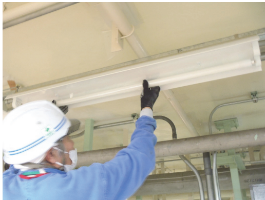
図 6.1.A1-7 照明設備の撤去・移設①
