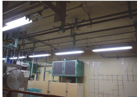
図 6.1.A1-2 移設作業前（照明）
