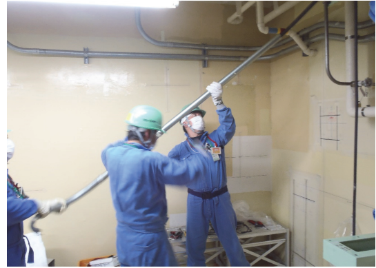
図 6.1.A1-6 監視カメラ電線管移設②
