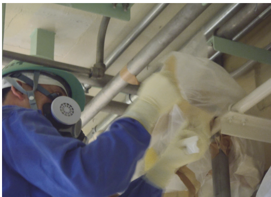
図 6.1.A1-9 配管の切断
