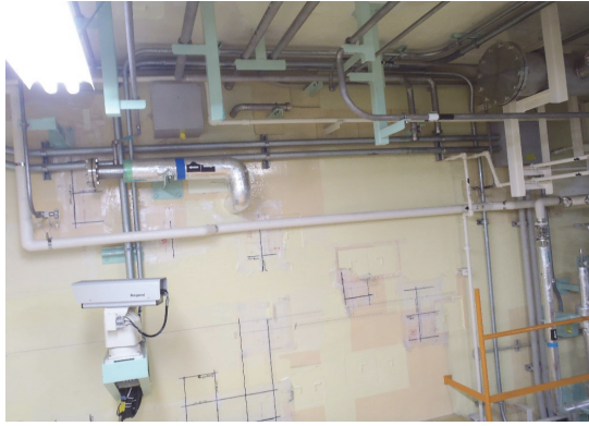
図 6.1.A1-13 撤去終了後（配管）
