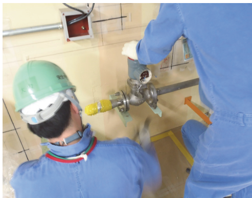
図 6.1.A1-3 気送設備（配管）撤去①
