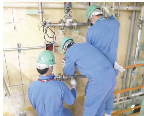
図 6.1.A1-4 気送設備（配管）撤去②
