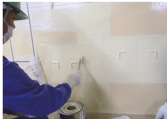
図 6.1.A1-12 撤去後の補修作業
