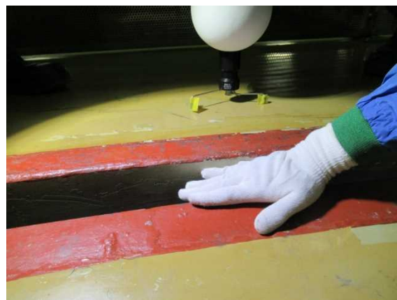
図 20 東端と DSP 側床面 (右図の左端) との間の状況 (敦賀 1 号機シールドプラグ) 10
