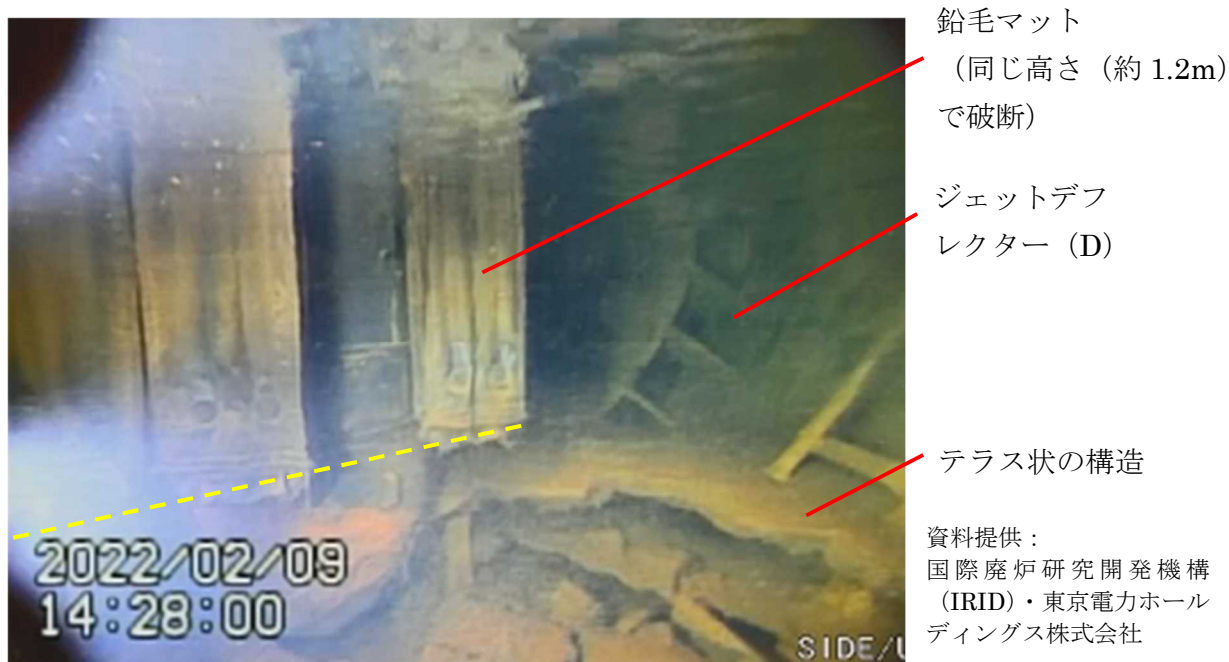
図5 ペDESTAL外周部（開口部付近）
