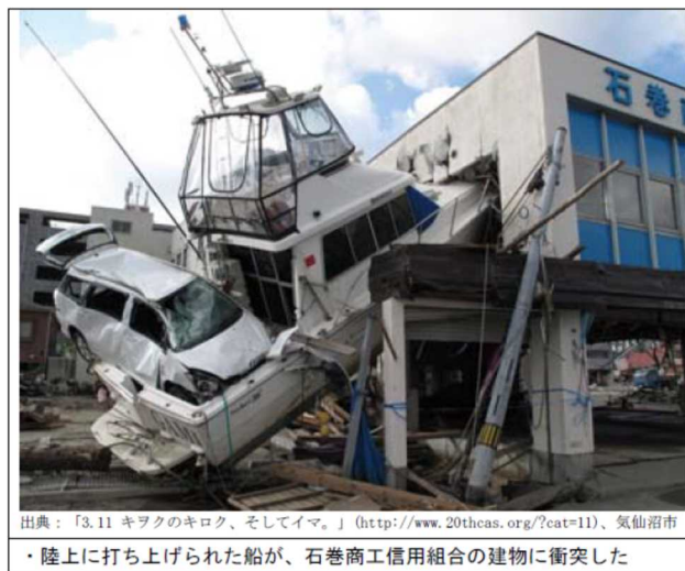
写-1.19 2011年東北地方太平洋沖地震津波により打ち上げられた漁船の衝突(宮城県石巻市)
