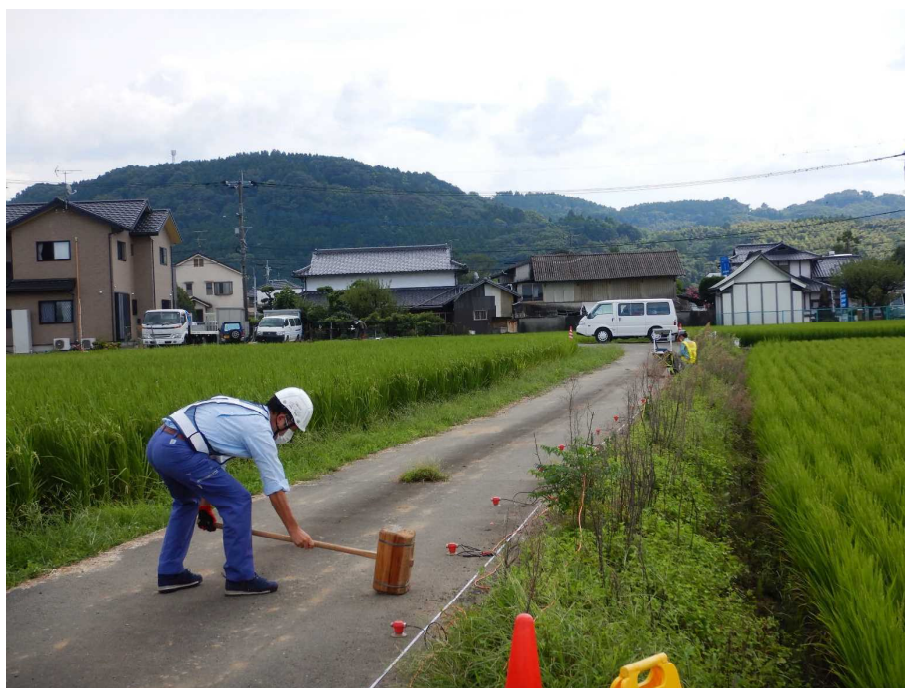
図 2.3.95 現地状況 (下町：測線状況)
