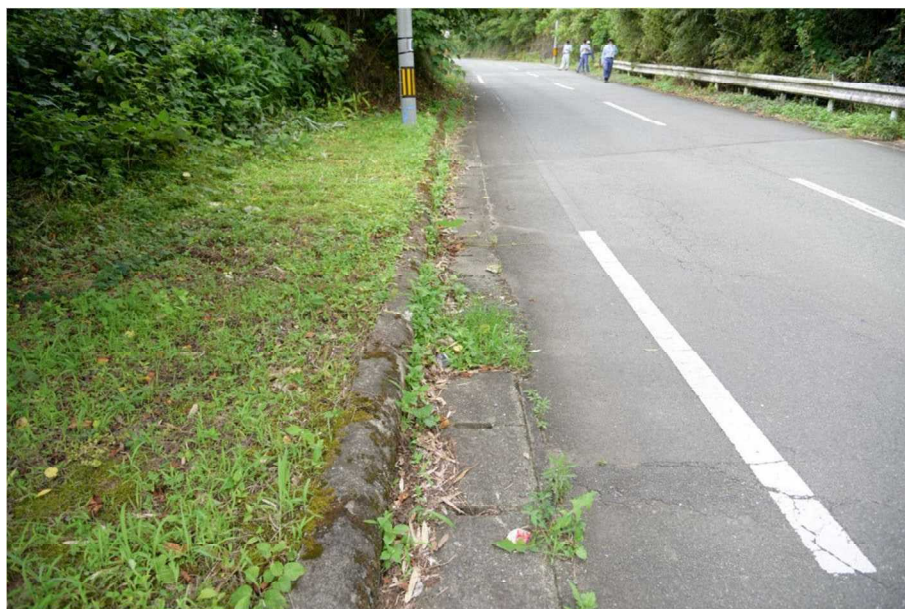
図 2.3.115 現地状況（堂園：西側測線、北側から望む）
