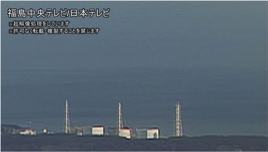
図 7 - 1 3号機における水素爆発時の原子炉建屋上部の火炎の状況 -2/60 秒
