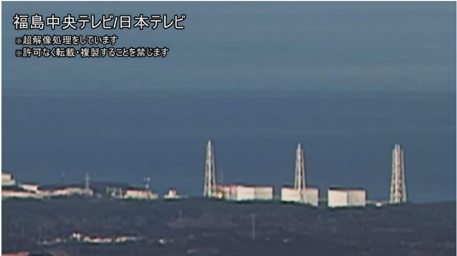
図6—2 1号機における水素爆発時の原子炉建屋上部の火炎の状況 0/60秒
