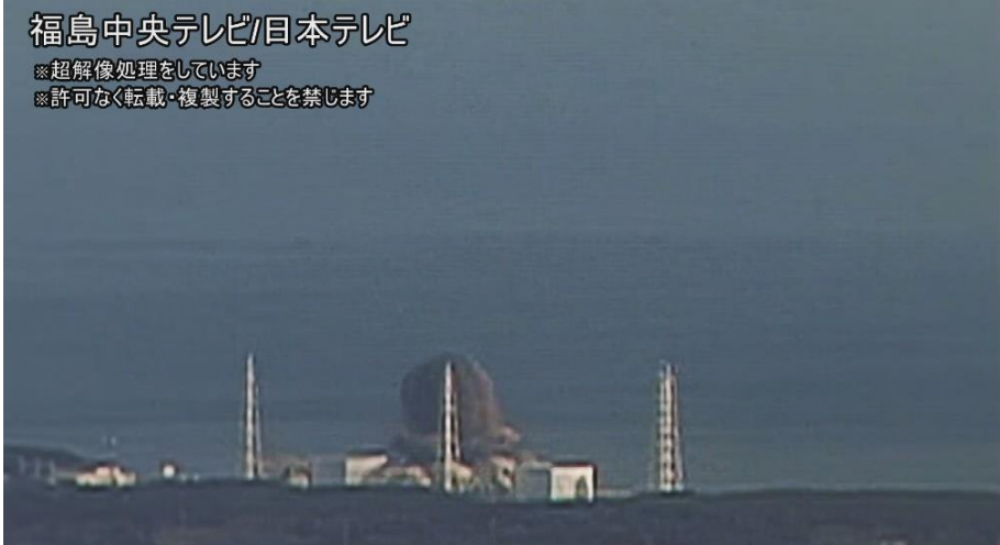
図5—3 3号機の水素爆発における噴煙等の状況 60/60秒
