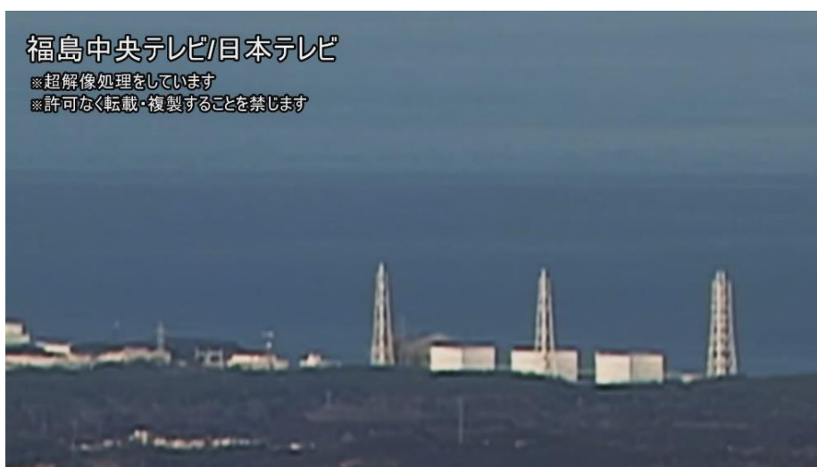
図4—1 1号機の水素爆発における噴煙等の状況 5/60秒
