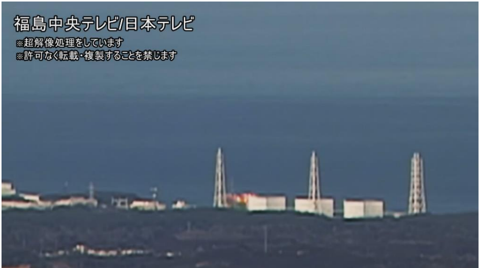
図6—3 1号機における水素爆発時の原子炉建屋上部の火炎の状況 1/60秒
