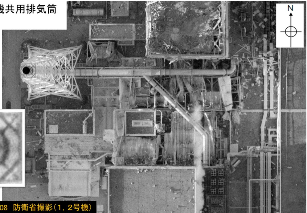
図5 1/2号機 SGTS 配管系の建屋外の状況 (航空写真)
