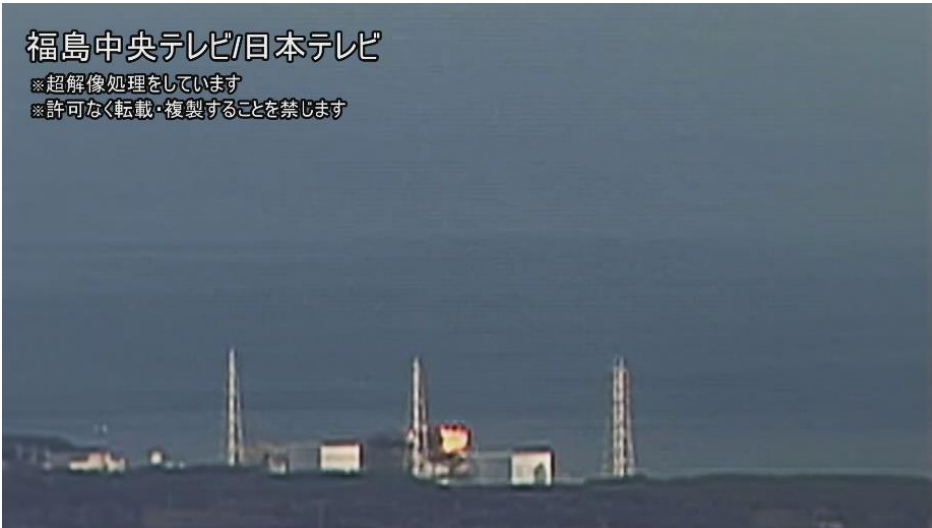
図 7-5 3号機における水素爆発時の原子炉建屋上部の火炎の状況 2/60 秒
