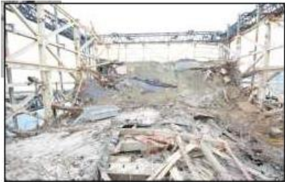
図6 1号機のオペフロの状況※
