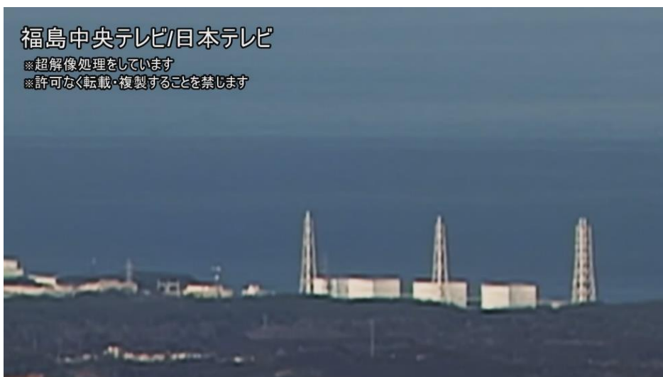
図6—1 1号機における水素爆発時の原子炉建屋上部の火炎の状況 -1/60秒
