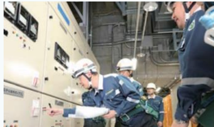
原子力規制検査の様子
