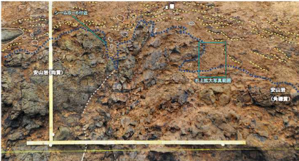
※写真、境界は第2回評価会合時に示したもののシームS-2・S-6 A. 北面中央調査箇所 拡大写真(礫、構造等を加筆)
