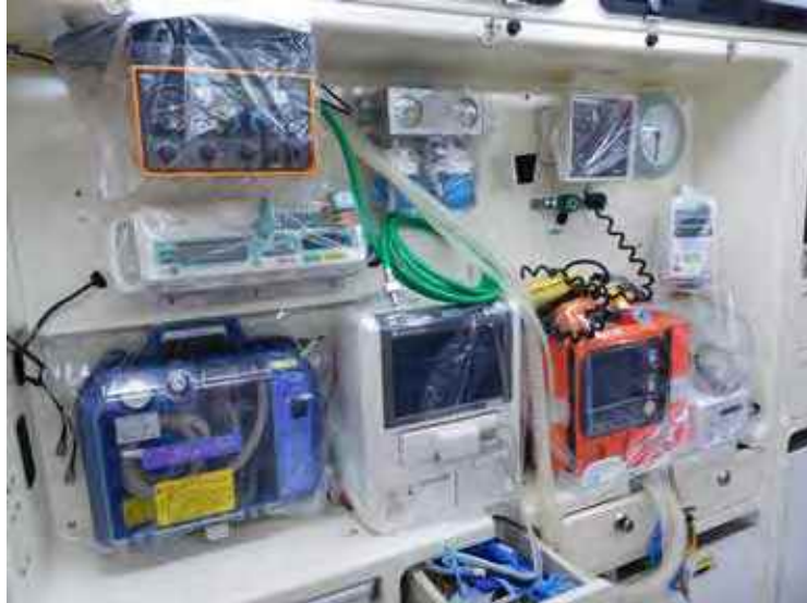
図 10. 医療器材の養生
