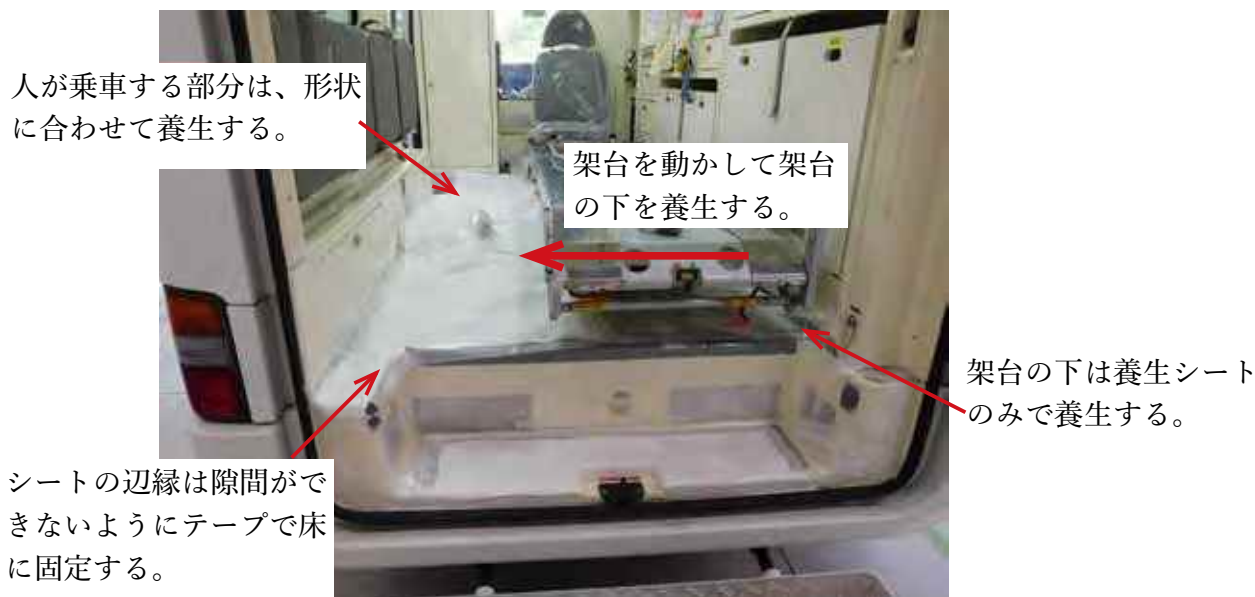
図 2. 救急車の床の養生
