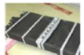
ファイアストップパの施工例
