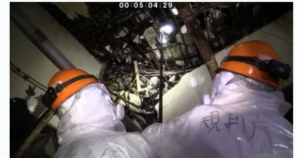
3号機原子炉建屋内調査(令和2年9月)
