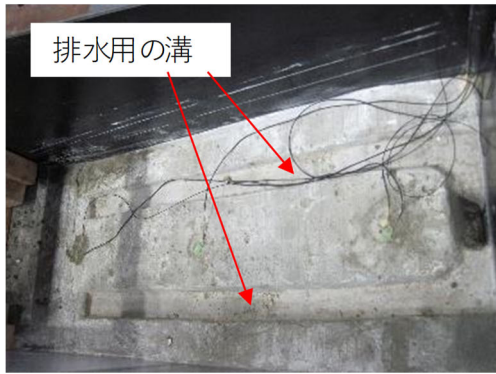
(a)排水用の溝掘削完了状況
