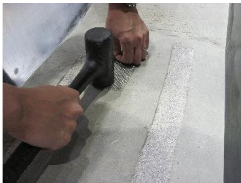
(a)金属製メッシュによる目荒らし状況
