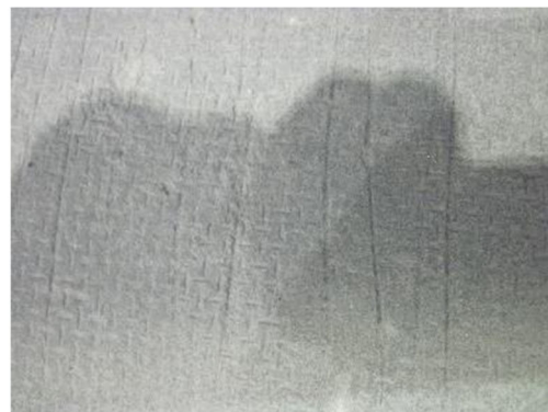
(b)目荒らし後の基盤層表面
