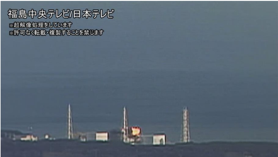
図 7-5 3号機における水素爆発時の原子炉建屋上部の火炎の状況 2/60 秒
