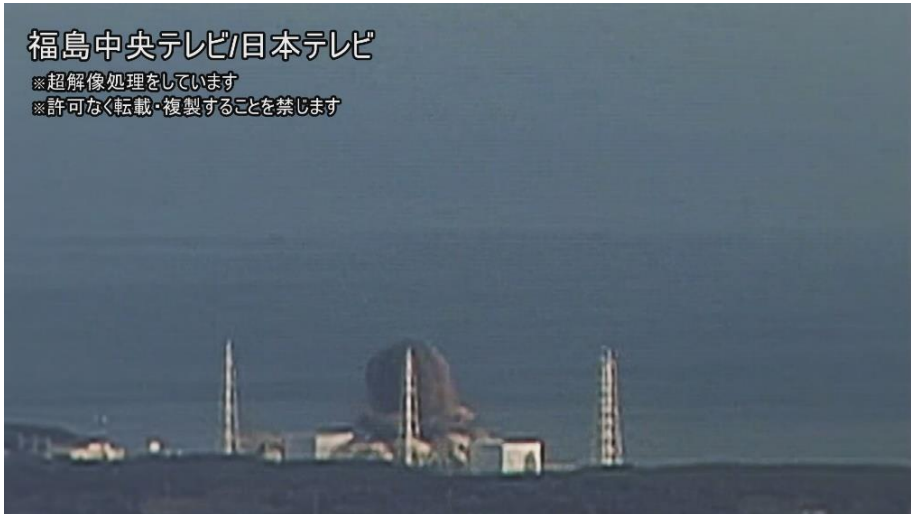
図5—3 3号機の水素爆発における噴煙等の状況 60/60秒
