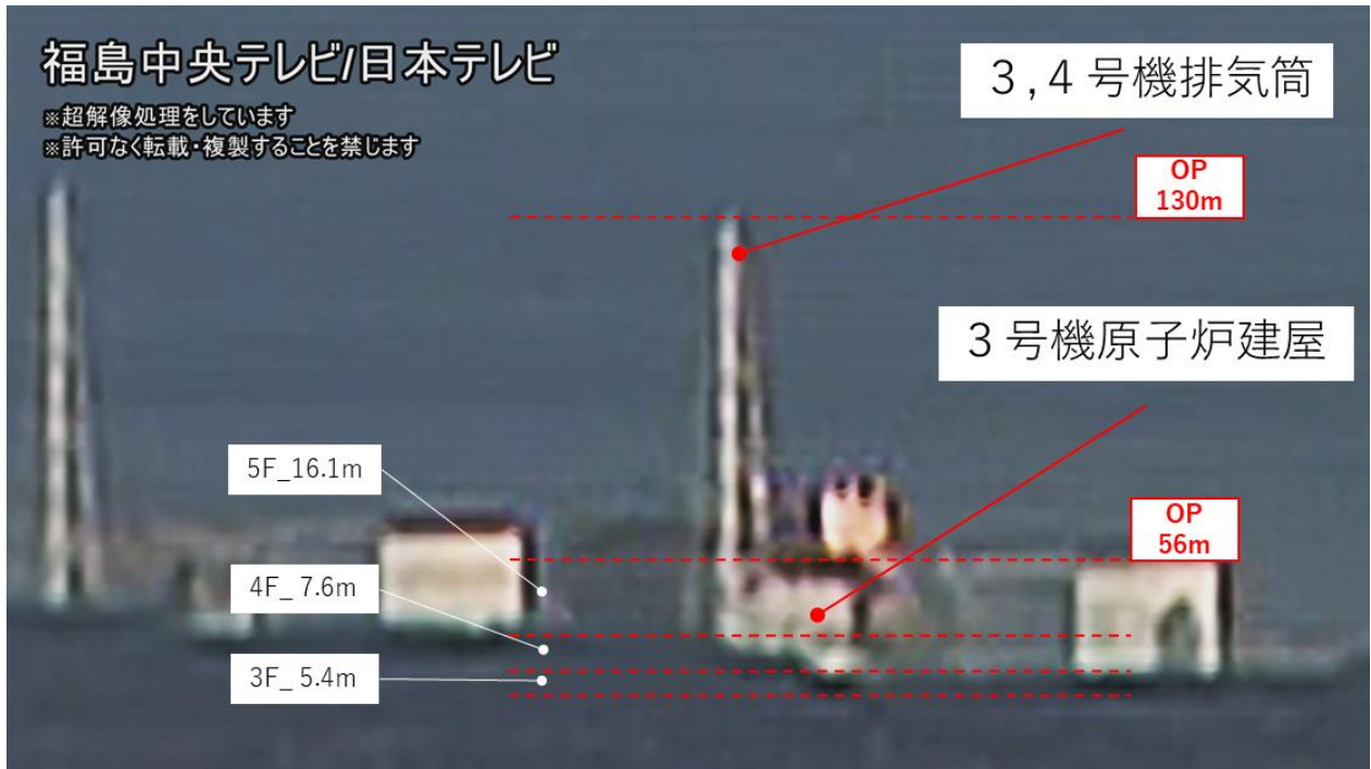
図1 3号機原子炉建屋の配置
