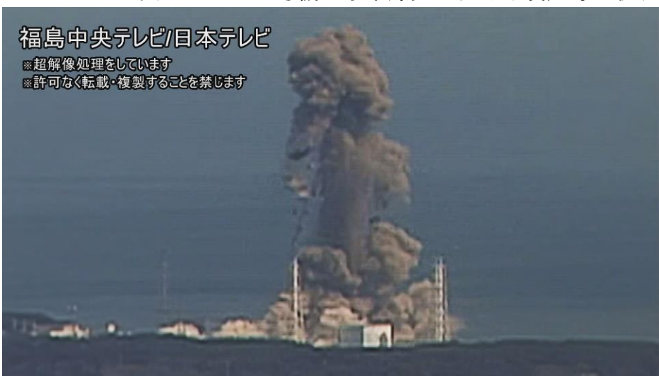
図5—5 3号機の水素爆発における噴煙等の状況 600/60秒
