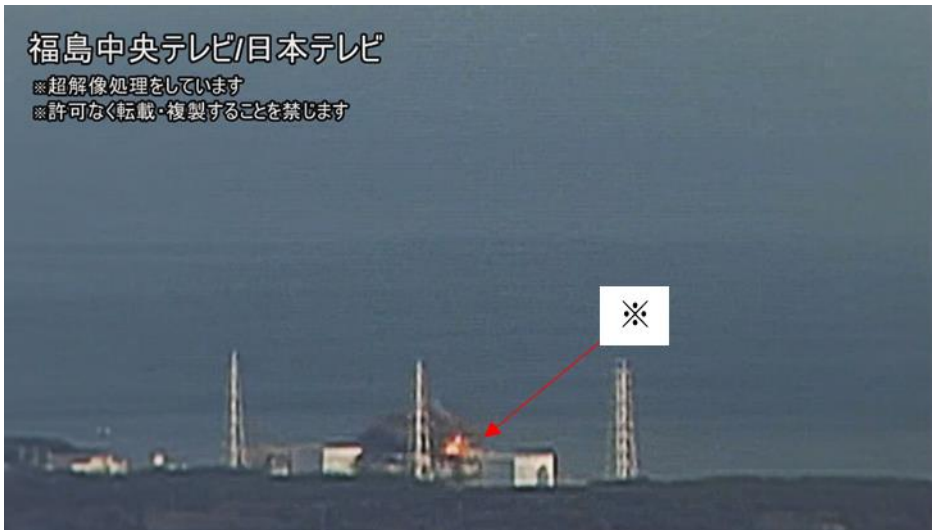
図 7-10 3号機における水素爆発時の原子炉建屋上部の火炎の状況 20/60 秒
