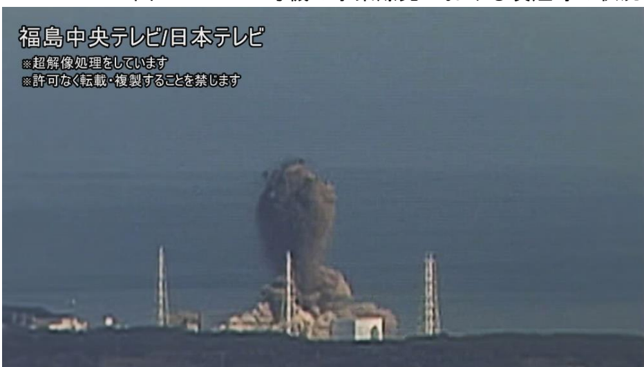
図5—4 3号機の水素爆発における噴煙等の状況 180/60秒
