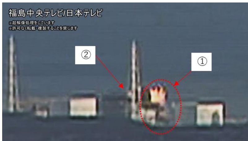
図 3-5 1/60秒時点での3号機原子炉建屋
