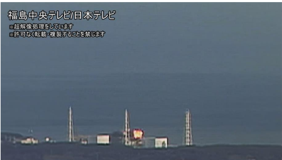
図 7-6 3号機における水素爆発時の原子炉建屋上部の火炎の状況 3/60 秒
