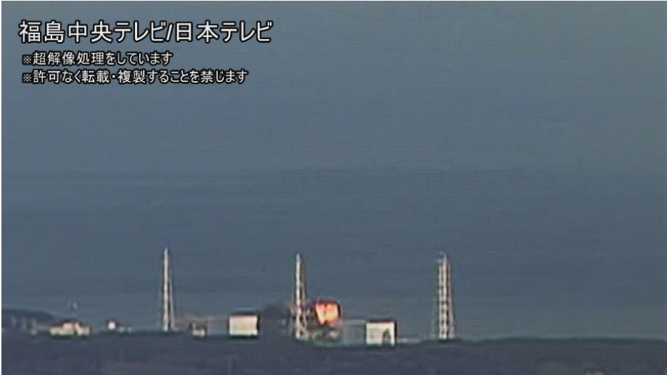
図 7-8 3号機における水素爆発時の原子炉建屋上部の火炎の状況 5/60 秒
