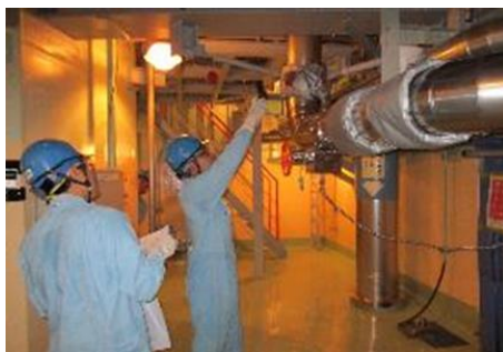
図 2-12-1 仮設遮蔽場所(A ループ室)の線量当量率測定の様子
