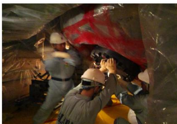
図 2-2 蒸気発生器マンホール開放作業の様子
