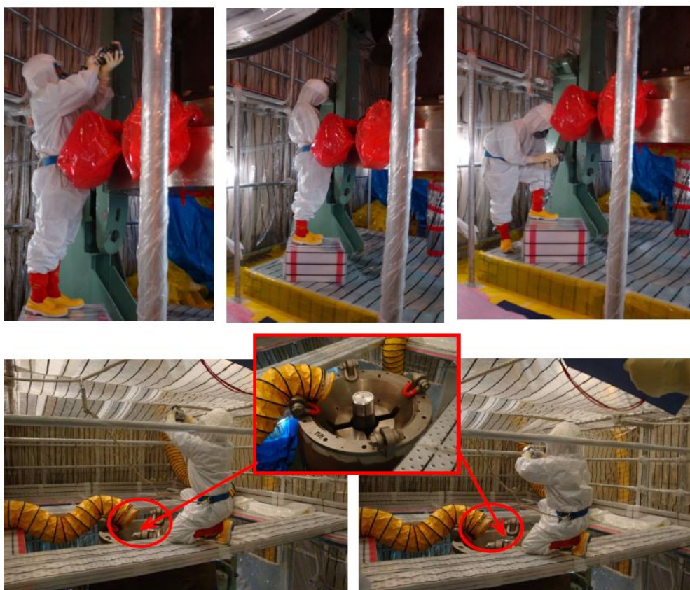
図 2-1 1 次冷却材ポンプインターナル分解点検作業場における電離箱サーベイメータによる線量率測定の様子
