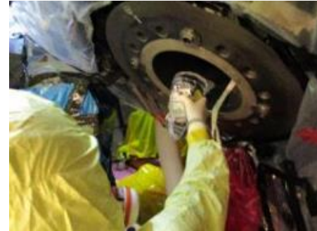
マンホール表面
