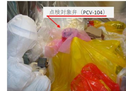
弁分解点検作業場
