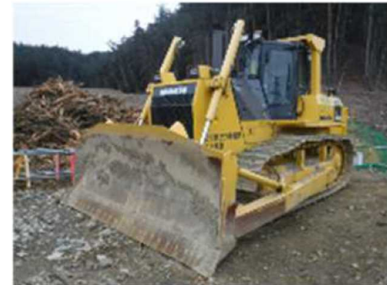
ブルドーザによるアクセスルートの復旧
