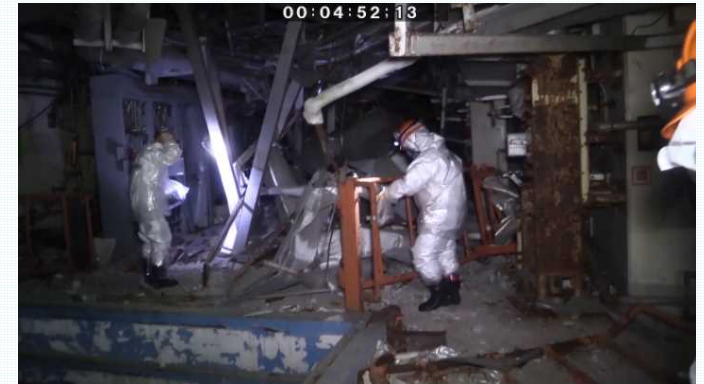
現場調査の様子(3号機原子炉建屋内)
