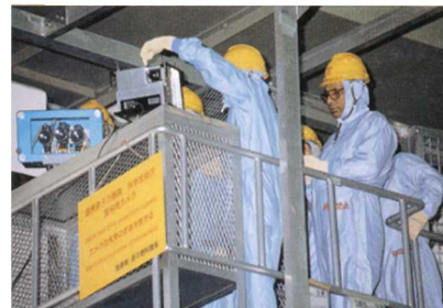
監視装置の保守管理
