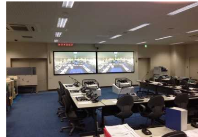
TV会議システム等通信設備
