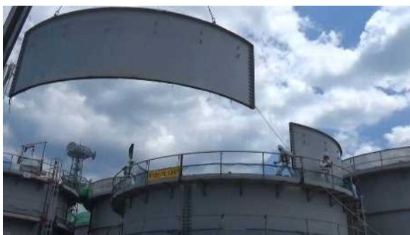
図3-1 フランジ型タンクの撤去イメージ (出典：東京電力ホールディングス)
