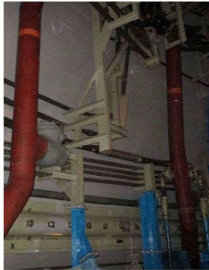
仮設足場組立前
