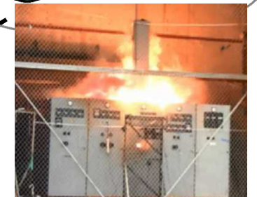
高エネルギーアーク損傷試験
