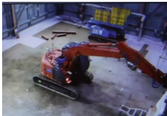
【写真2】現場 重機 状況（解体用ブラケットによる梁の除去）
