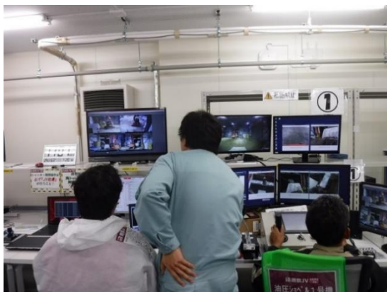
【写真3】免震重要棟 遠隔操作室 操作状況
