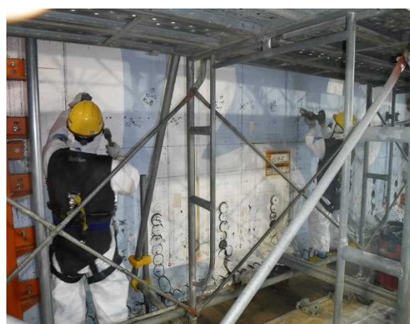
【写真10】 目地切り箇所のスミだし
