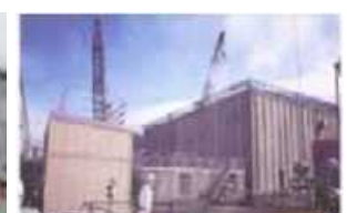
水処理二次廃棄物 (2) （スラッジ）
