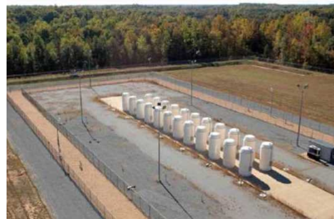
使用済燃料貯蔵施設の例(米国North Anna発電所)
