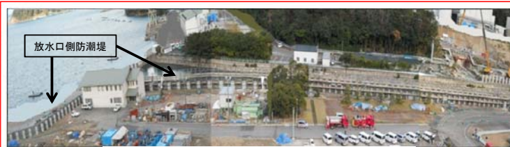
放水口側防潮堤
