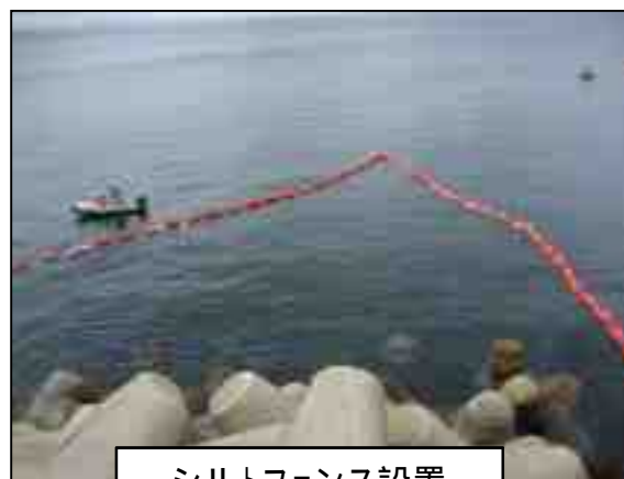
シルトフェンス設置
