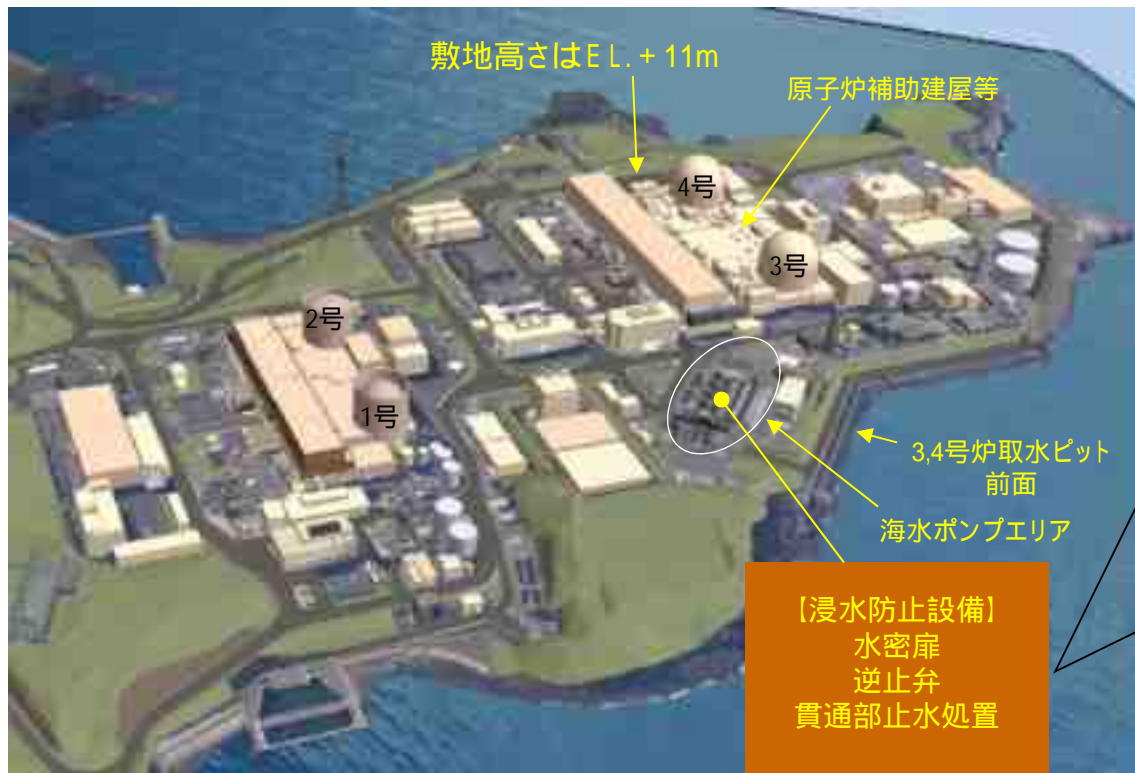
海水ポンプエリアの津波対策
