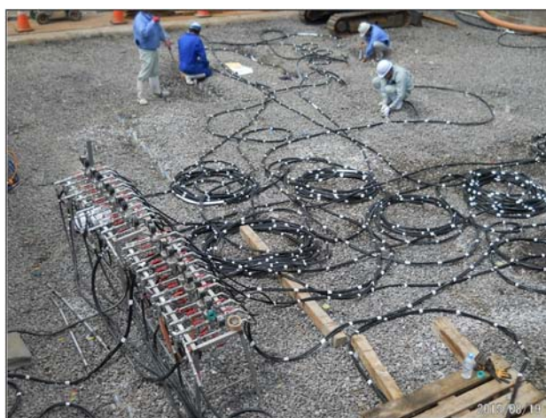
図-2 現場施工状況
