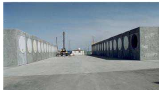
米国TMI-2で使用されている貯蔵システム
