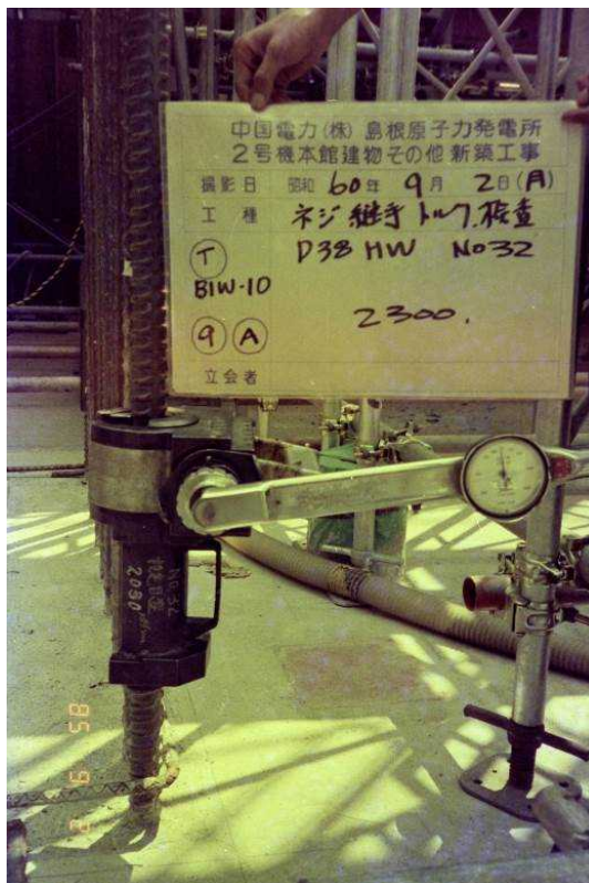
写真2 配筋検査状況
