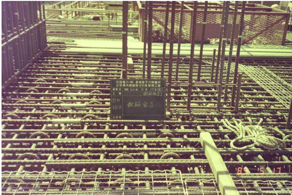
写真4 配筋検査状況
