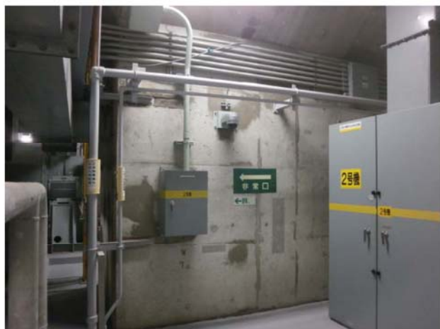
タービン架台(2号炉)
