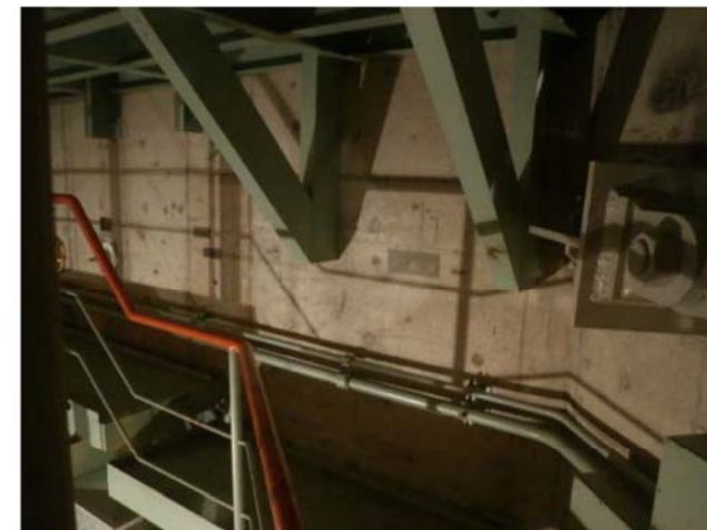
原子炉格納施設等 内部コンクリート(2号炉)
