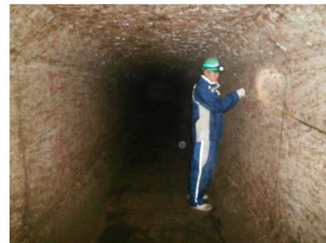
非常用海水路(1号炉)
