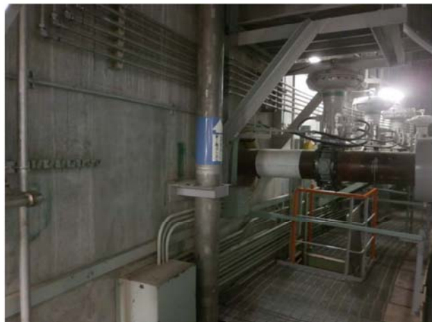
原子炉格納施設等 外部遮蔽壁(1号炉)
