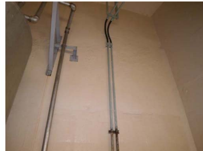
原子炉格納施設等 基礎マット(1号炉)
