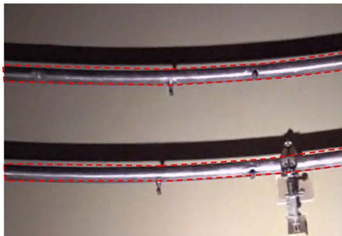
内面高所のうち従来の点検で確認が容易でない範囲
