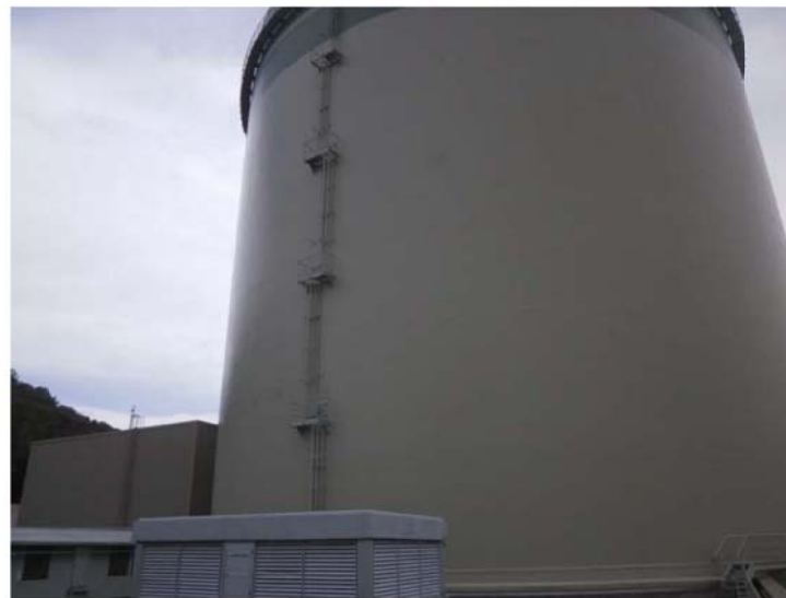
原子炉格納施設等 外部遮蔽壁(1号炉)
