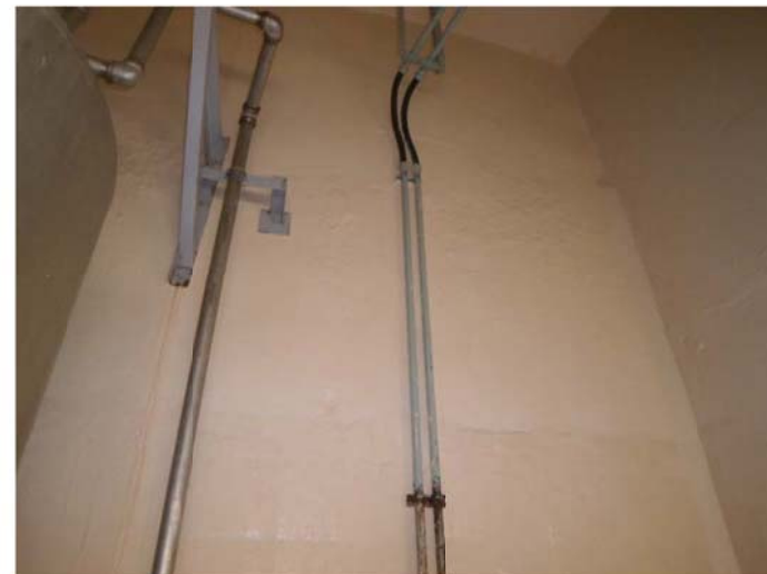
原子炉格納施設等 基礎マット(1号炉)
