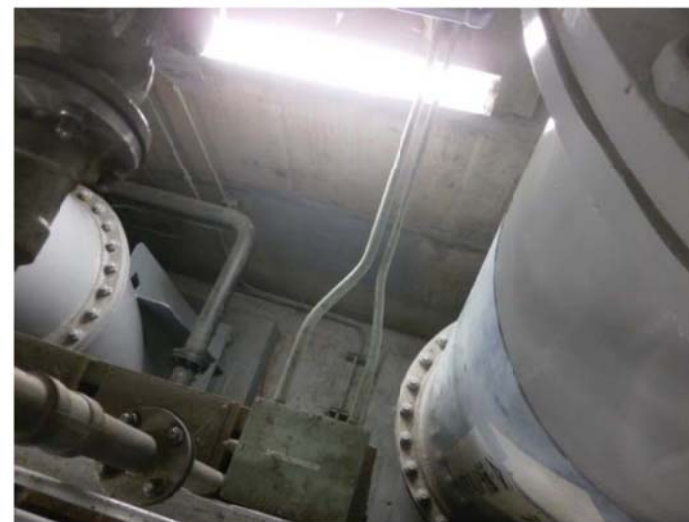
原子炉補助建屋 基礎マット(1号炉)
