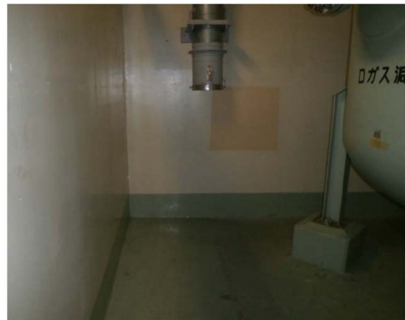
原子炉補助建屋 外壁(1号炉)
