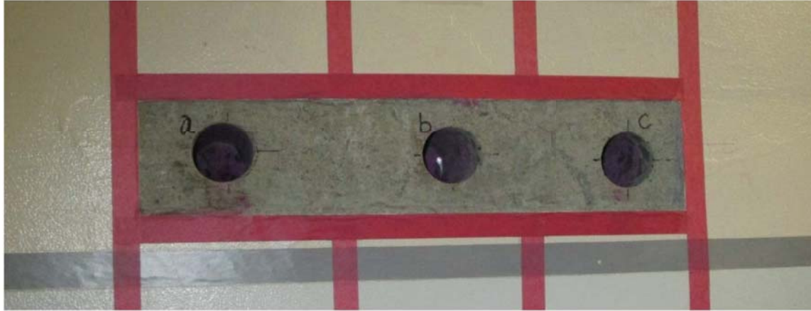
中性化の点検状況
