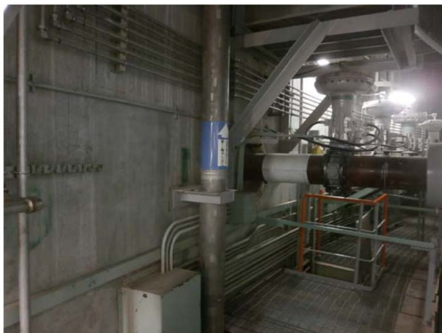
原子炉格納施設等 外部遮蔽壁(1号炉)
