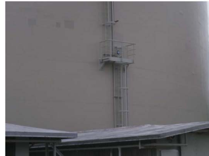
原子炉格納施設等 外部遮蔽壁(1号炉)
