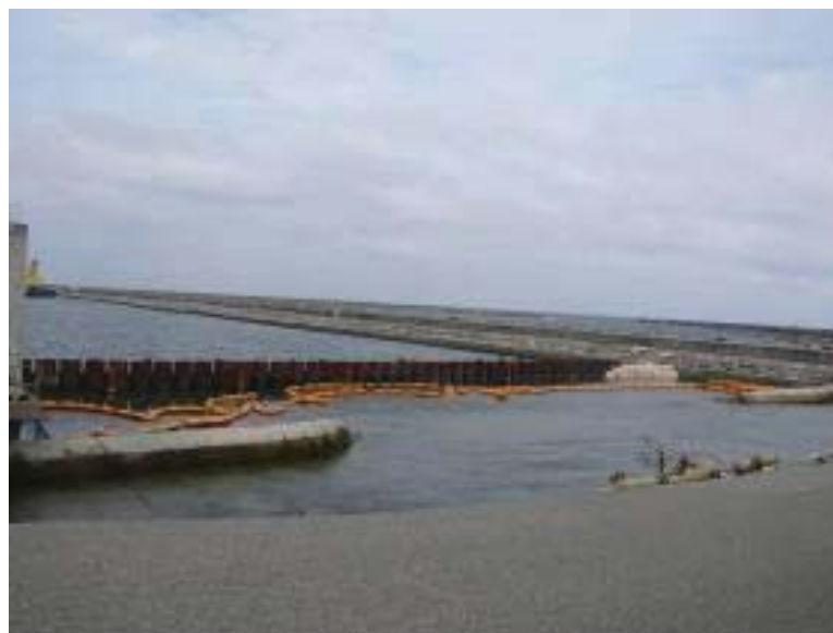
鋼管矢板設置状況
