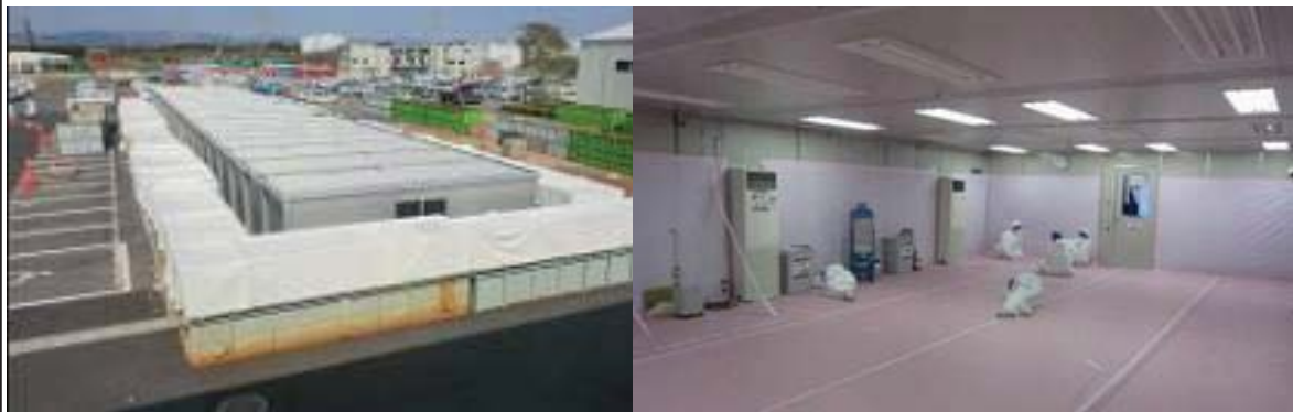
現場休憩施設外観(左)と内観(右)
