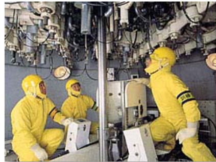
原子炉下部での制御棒駆動機構の保守訓練 (中部電力提供)
