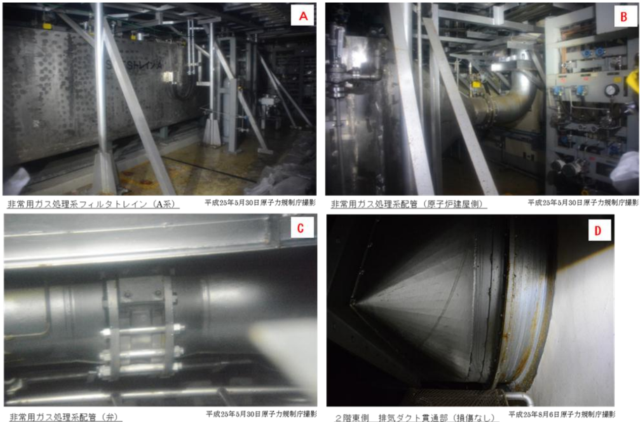
図7. 6 非常用ガス処理系フィルタトレイン、配管及び排気ダクト貫通部の状況
