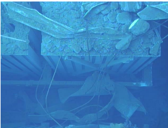
図 6. 1 3号機使用済燃料貯蔵プール内の状況
