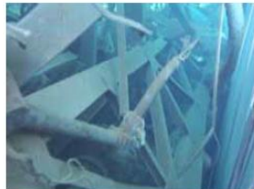
画像④：燃料交換機の歩廊部の状況
