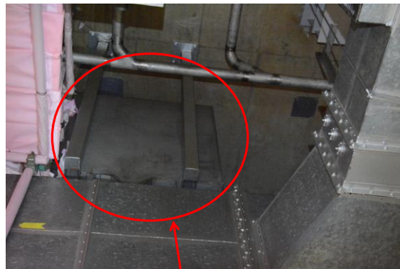
5号機南西側の溢水防止チャンバ
