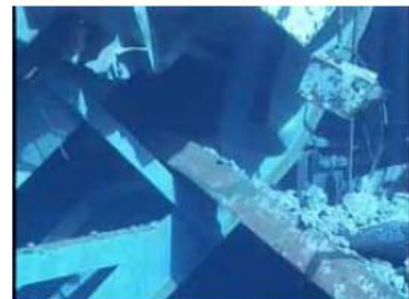
画像⑤：燃料交換機のブリッジ
