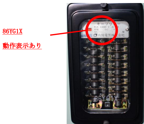
図 2. 20 主発電機のロックアウトリレー
