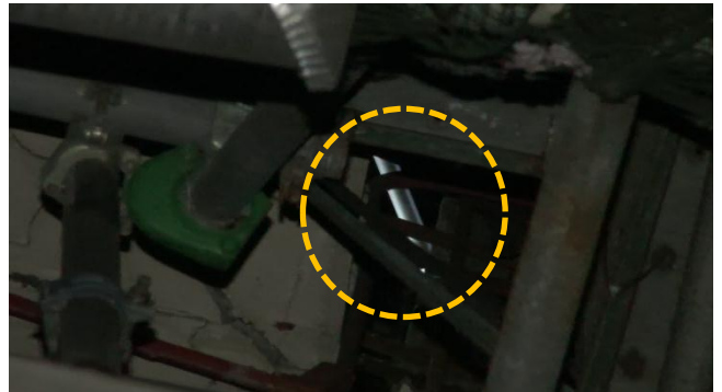
平成 26 年 2 月 6 日原子力規制庁撮影 貫通部拡大（3 階の原子力規制庁の調査資材を視認）
