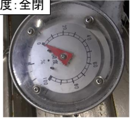
<IC(B系)(2B)開度計>
