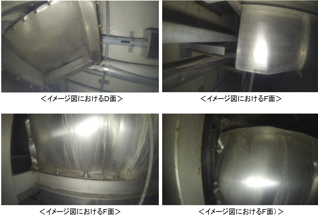
図3. 9 溢水防止チャンバの状況（2）
