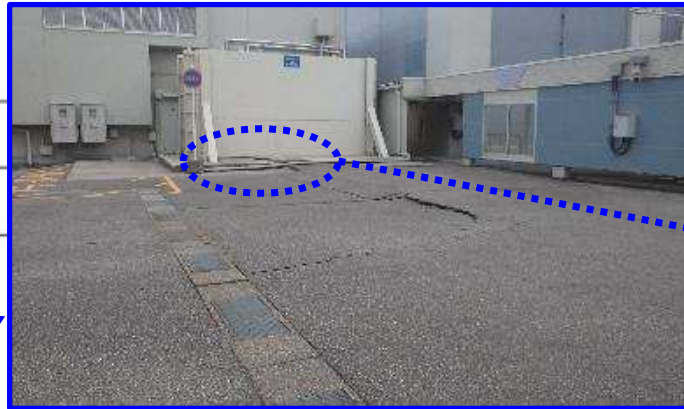
1号機 補機冷却排水連絡槽防潮壁 (外側)
