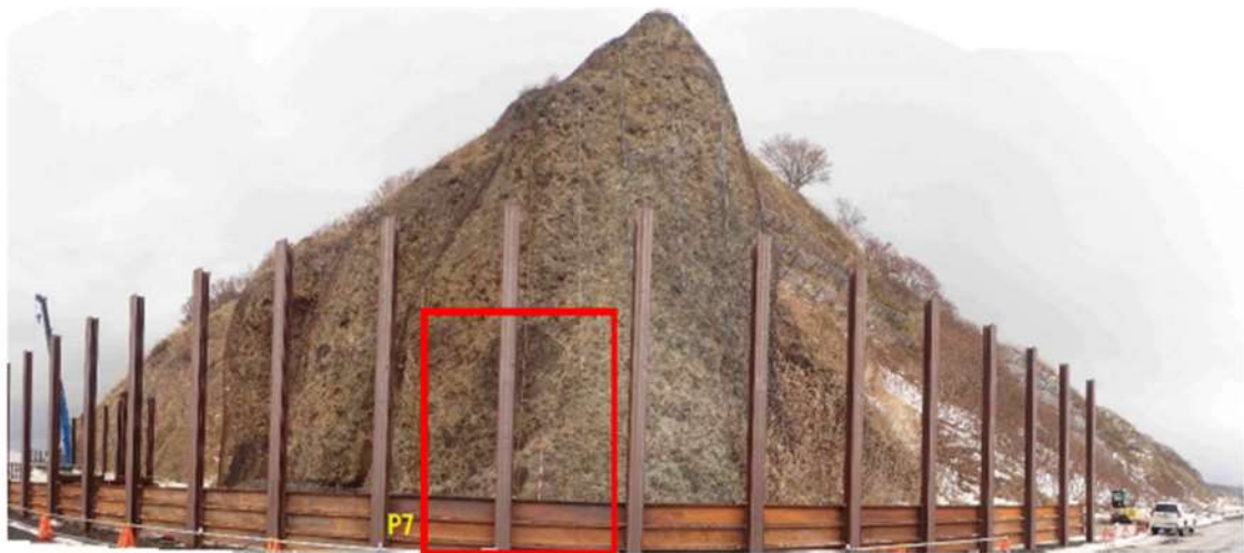
図 2.1.a.c-7 (6) 防潮堤（堀株側）露頭状況 P6 防潮堤擦り付け部周辺（P5 拡大） 露頭全面に凝灰角礫岩が分布する。
