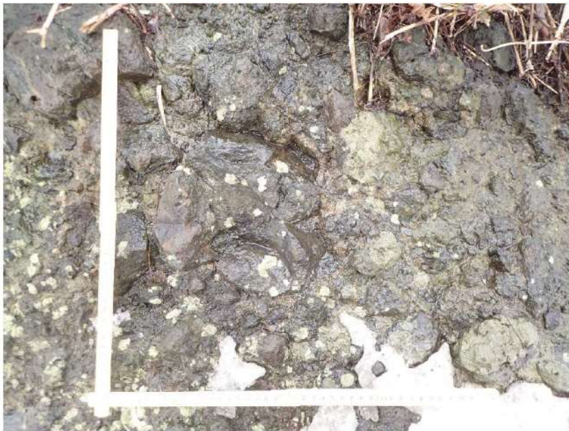
図 2.1.a.c-4 (18) 防潮堤（茶津側）露頭状況 P18 茶津川沿いの地山斜面下部（P17 拡大） 凝灰角礫岩が分布し、B 級からなる。
