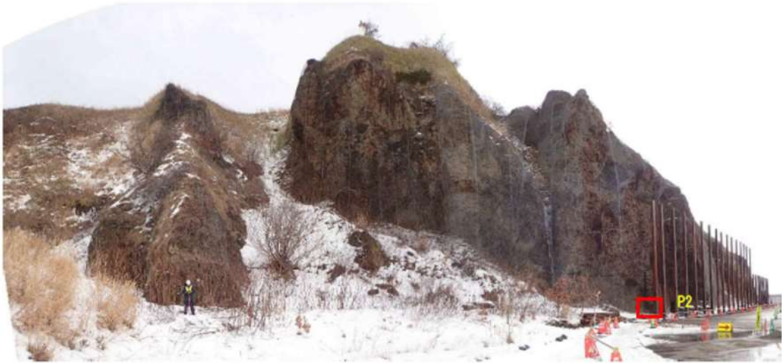
図 2.1.a.c-7 (1) 防潮堤（堀株側）露頭状況 P1 防潮堤擦り付け部全景 露頭全面に凝灰角礫岩が分布する。
