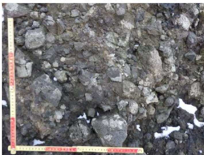
図 2.1.a.c-4 (11) 防潮堤（茶津側）露頭状況 P11 岬の近景（山側）（P10 拡大） 凝灰角礫岩が分布し、C級からなる。
