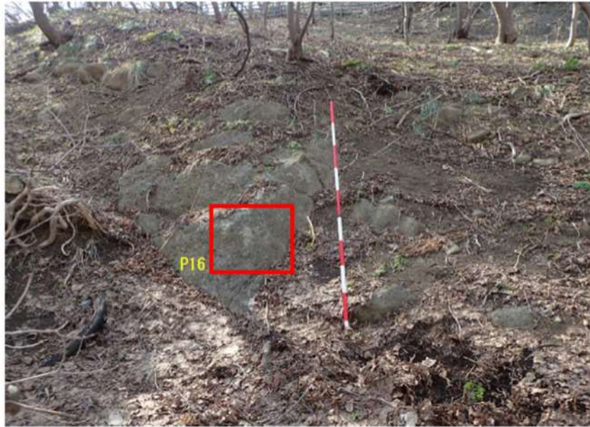
図 2.1.a.c-4 (15) 防潮堤（茶津側）露頭状況 P15 茶津川沿いの地山斜面下部（P12 拡大） 凝灰角礫岩の露頭が分布する。
