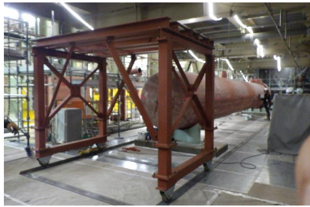
給水加熱器切断時の仮設揚重設備の設置
