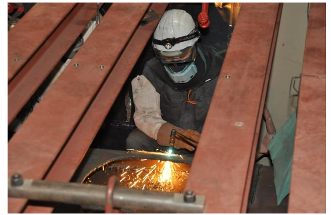
給水加熱器胴部のガス溶断作業
