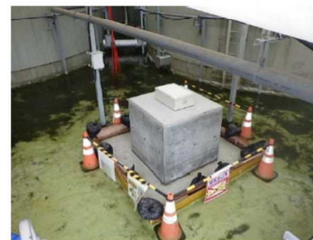
内堰基礎部に設置後
