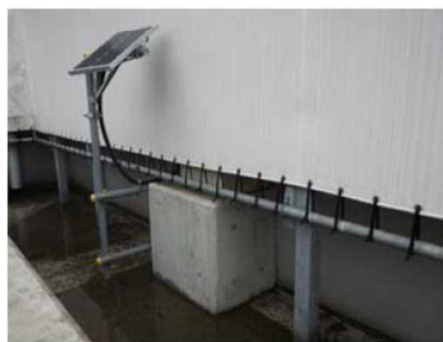
内堰外側に設置時
