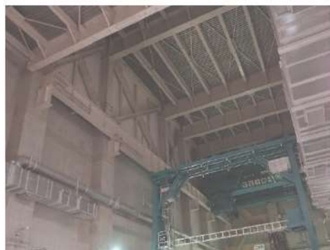
図 5.2.2 燃料取扱棟の屋根
