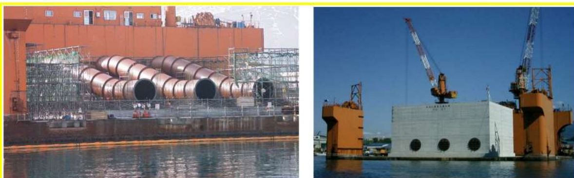
【建設時（曳航前）】鋼製管全景（コンクリート巻き立て前）
