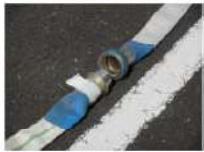
③ 可搬型ホース接続前
