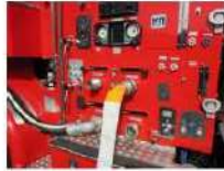
② ポンプ車へ吐出ホース接続後
