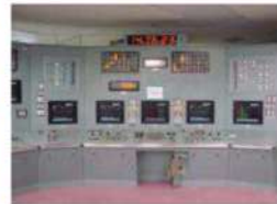
通常点灯時 (非常用照明及び直流照明兼非常用照明)
