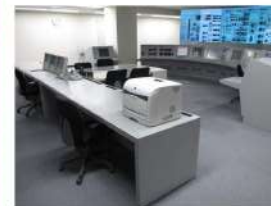
通常点灯時 (運転員安灯及び制御室運転員安灯)
