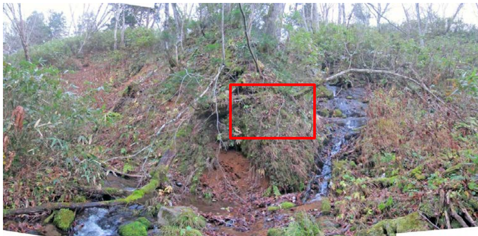
ON7:ブロック15末端部, 枝沢合流箇所, 河床に神恵内層の変質安山岩が分布する。
