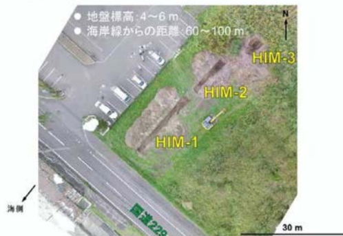
図3 せたな町平浜地区でのトレンチ掘削地点の地形と掘削位置
