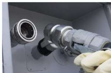
代替非常用発電機の給油口へのホース接続 (クイックカップラ式) (代替非常用発電機) (屋外)
