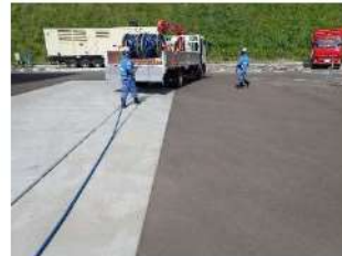
号炉間連絡予備ケーブル敷設（屋外）
