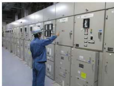
メタクラ電源確認 (安全補機開閉器室) (原子炉補助建屋T.P. 10. 3m)
