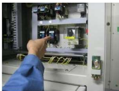
受電遮断器操作 (安全補機開閉器室) (原子炉補助建屋T.P. 10. 3m)
