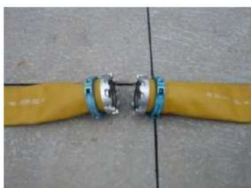
可搬型ホース（150A）接続前
