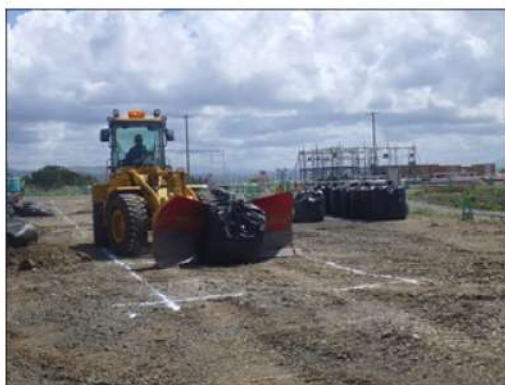
図4 がれき撤去訓練
