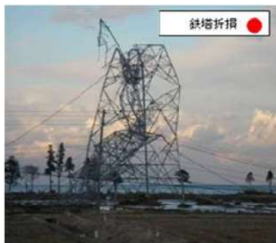
津波による隣接鉄塔の倒壊に伴う送電鉄塔の倒壊事例 ※2
