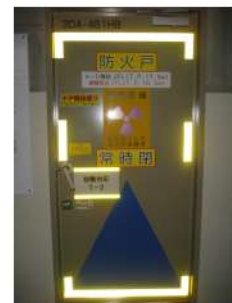
図 16 扉への反射テープ貼り付け例
