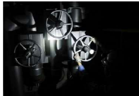
可搬型照明（ヘッドライト）を使用した状態
